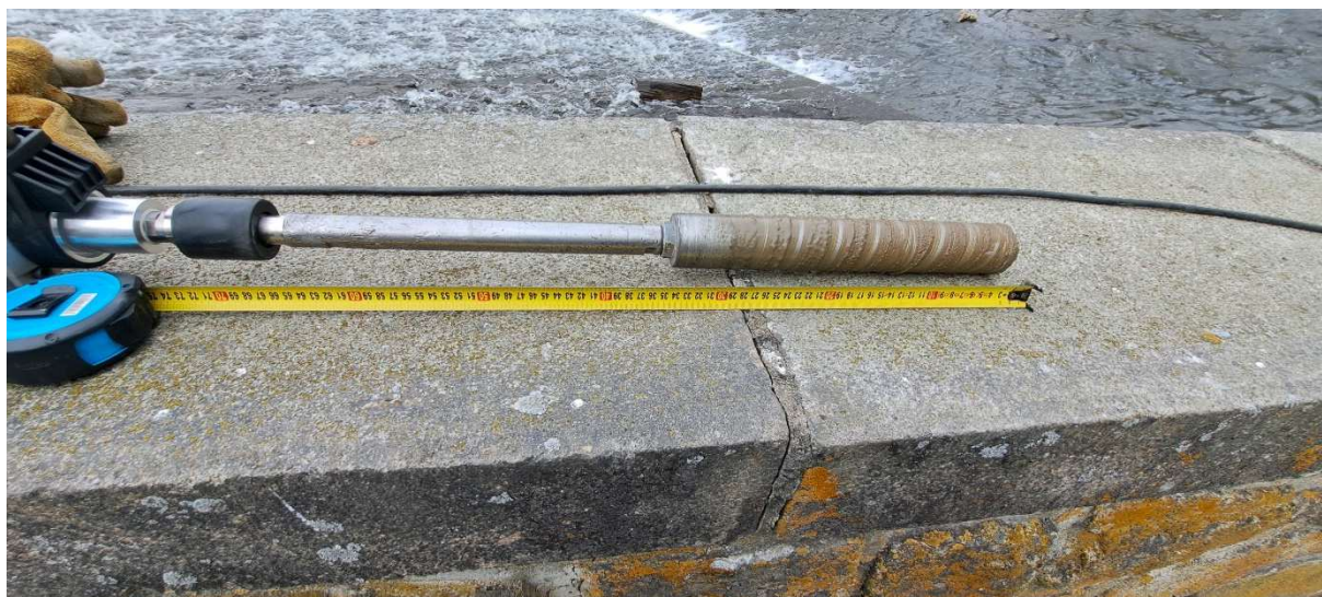
4. Jádrové vrtání do levobřežní zdi
