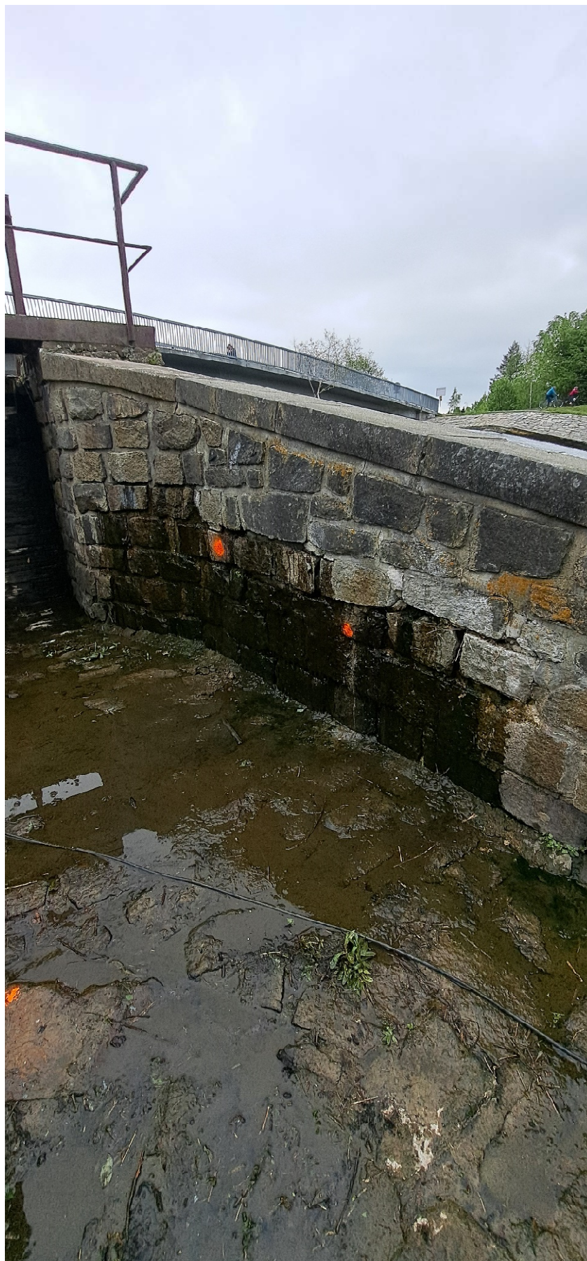
2. Označení vrtů levobřežní zdi
