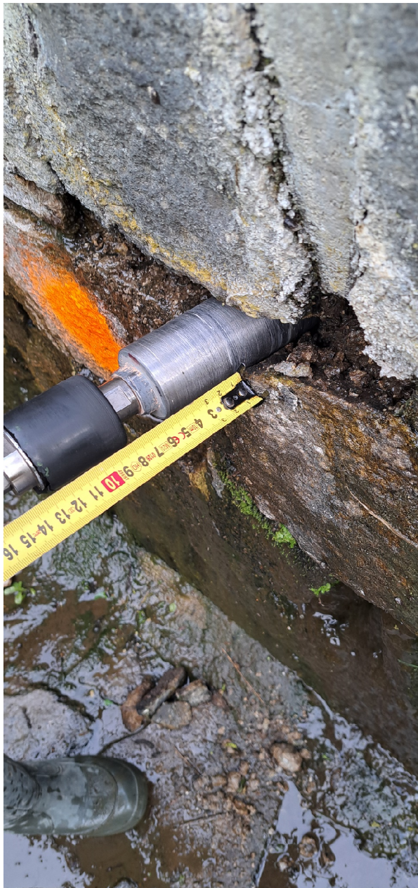
3. Jádrové vrtání do levobřežní zdi
